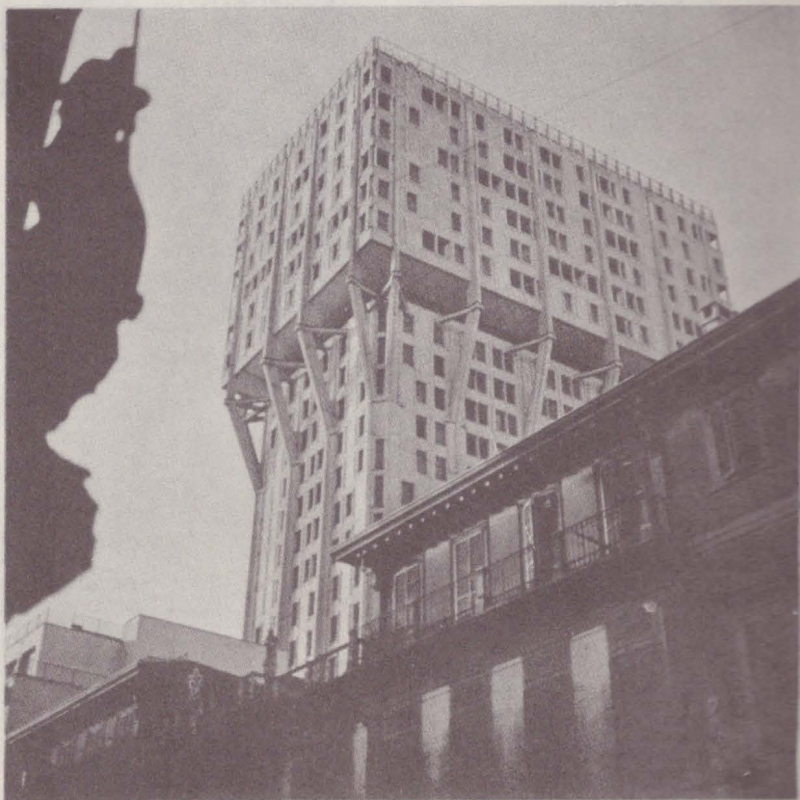
BELGIOSOSO - Peressutti - Rogers; Torre Velasco, Milan; 1056 - 58.
